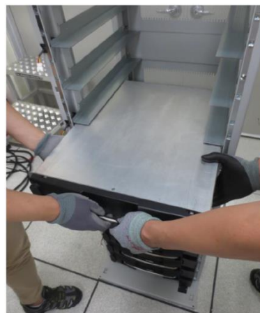
Abb. 18: Einbau der Batteriemodule
