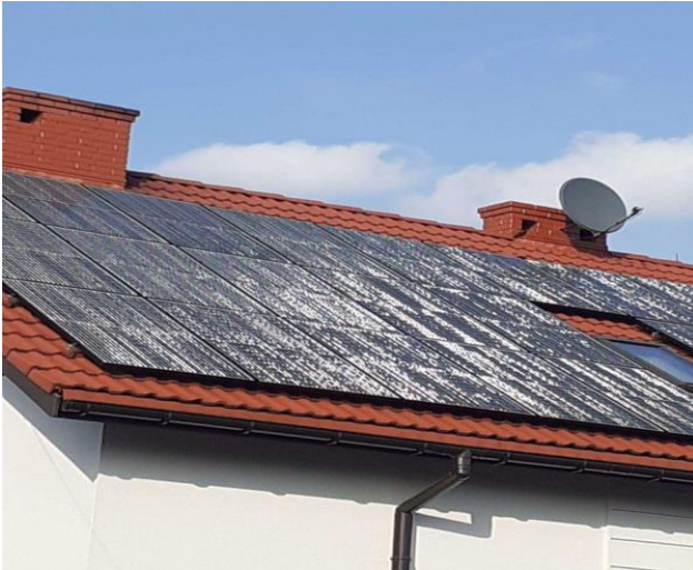
Abb.1 LRF-Effekt an einem sonnigen Tag
